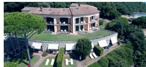
vista aerea facciata ovest stato attuale
